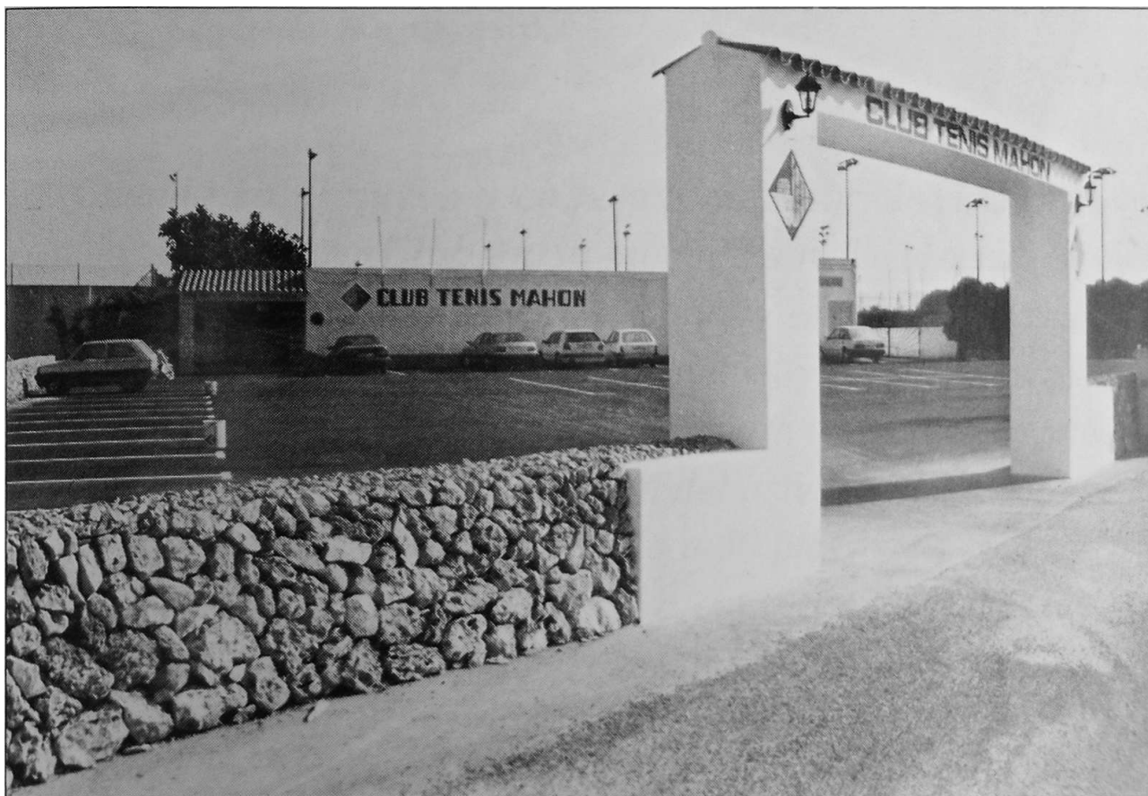
Cierre del aparcamiento del Club por medio de pared seca.
